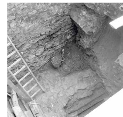
Západní část větší místnosti se zbytky někdejší klenby. Dole schody do lázně. Foto neznámého autora z roku 1968, archiv Národního památkového ústavu, územní odborné pracoviště v Praze
