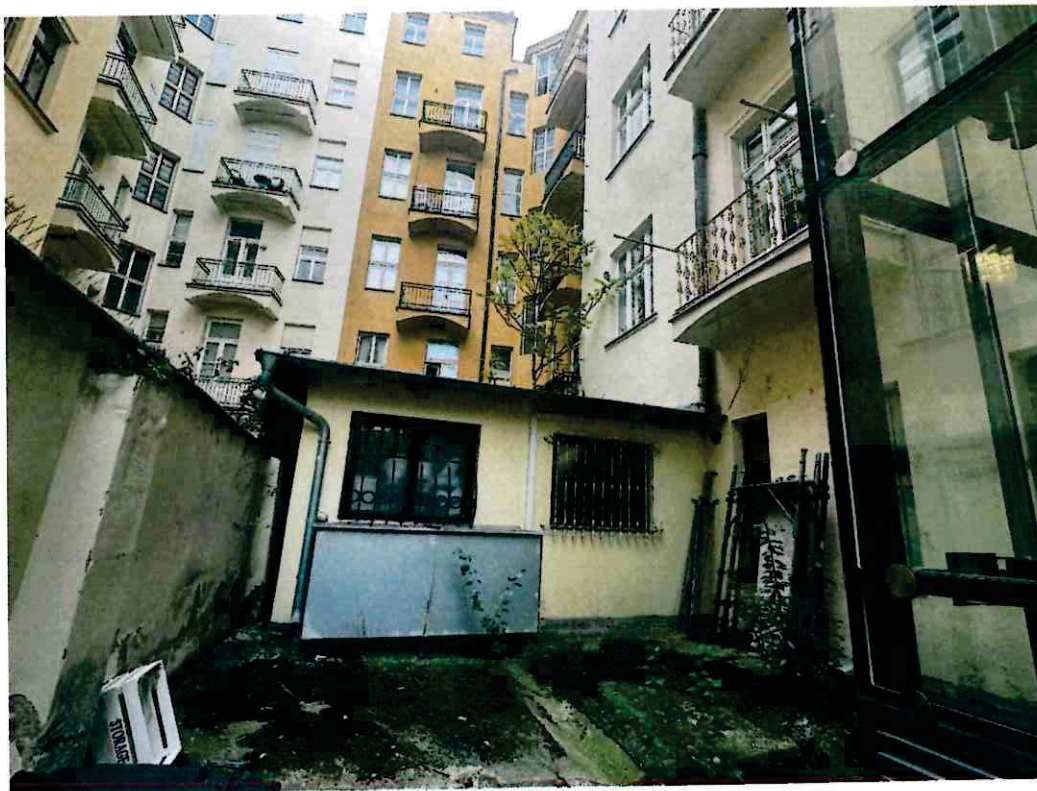
Foto č.1 : obohacení - stavba + hlučné agregáty
